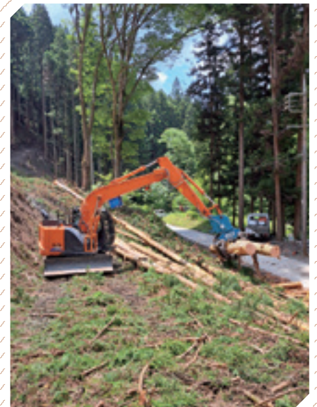
グラップルによる集材作業
