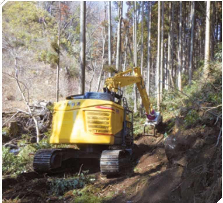
作業道開設状況
