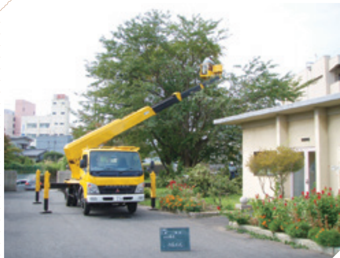
高所作業車による伐採作業
