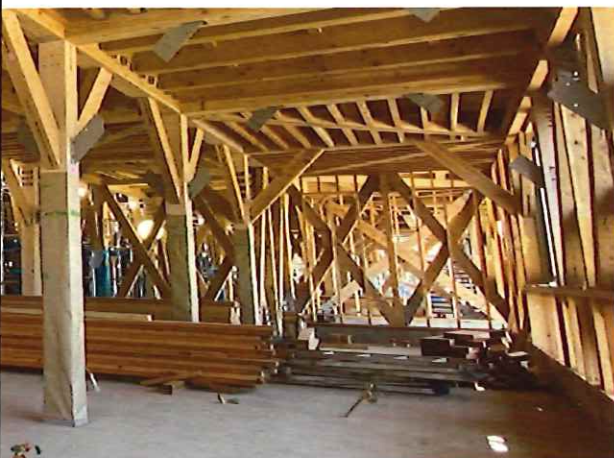
建設中（行政棟1階部分）
