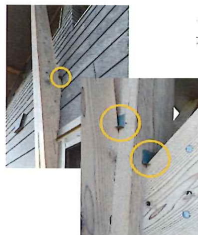
水除け金具の設置
